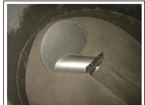
Installierte RW Wirbeldrossel einbetoniert in Rinne bei Schachtauslauf
